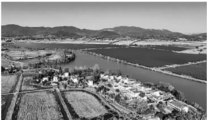
安徽省芜湖市繁昌区平铺镇岱湖滩渔光互补光伏电站,水上发电、水下养殖,助力节能减排(人民图片 鲁君元/摄)
