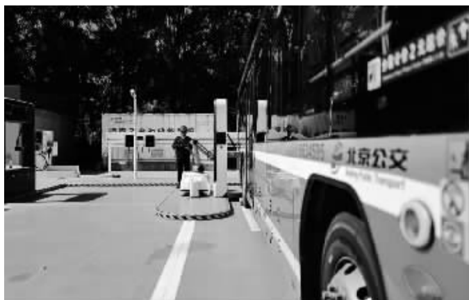
国网北京电力员工检测电动公交车充电设备
